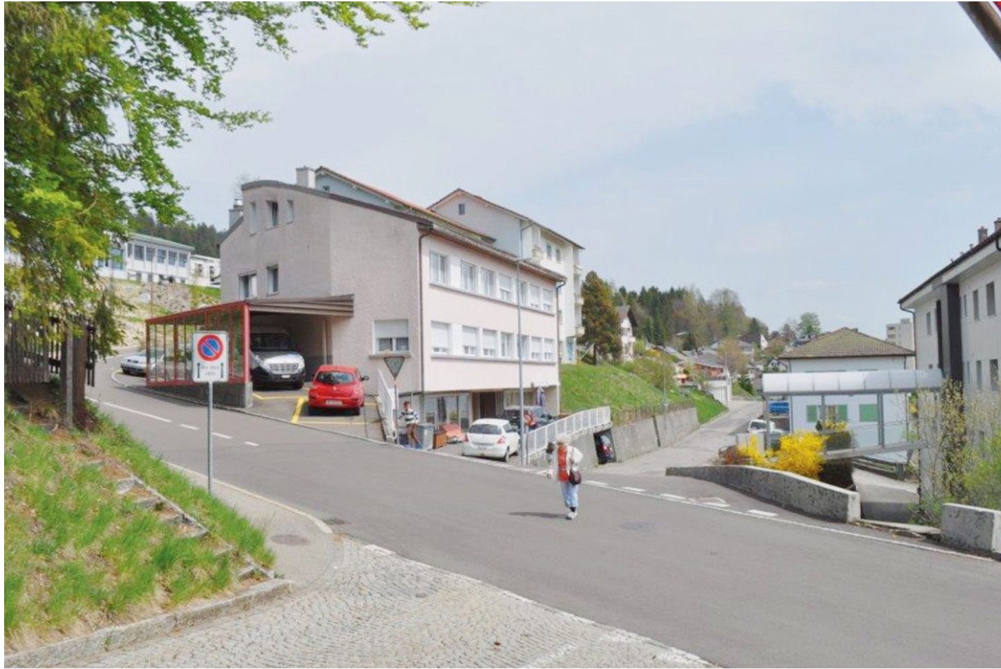
La réfection de la rue Crêt-Georges sera complétée par l'aménagement du carrefour Combe-Aubert et d'un passage piétons. DR
