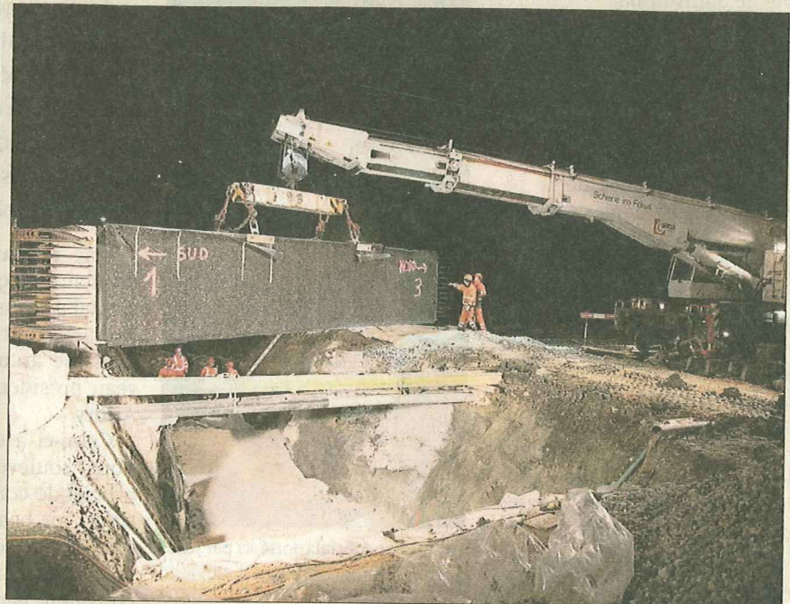
Le secteur concerné par ces travaux se situe du côté est de la gare de Reconvilier. Après avoir creusé une fosse de quatre mètres de haut et procédé aux mesures minutieuses, le canal dans lequel coulera le Bénévis a été posé par la plus grande grue des CFF. La correction du lit de ce ruisseau s'inscrit dans le cadre des mesures anticrues décidées par les autorités.
