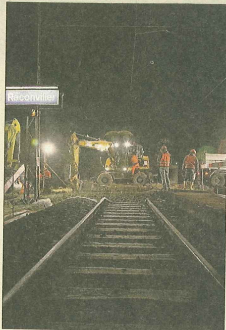
Le secteur concerné par ces travaux se situe du côté est de la gare de Reconvilier. Après avoir creusé une fosse de quatre mètres de haut et procédé aux mesures minutieuses, le canal dans lequel coulera le Bénévis a été posé par la plus grande grue des CFF. La correction du lit de ce ruisseau s'inscrit dans le cadre des mesures anticrues décidées par les autorités.
