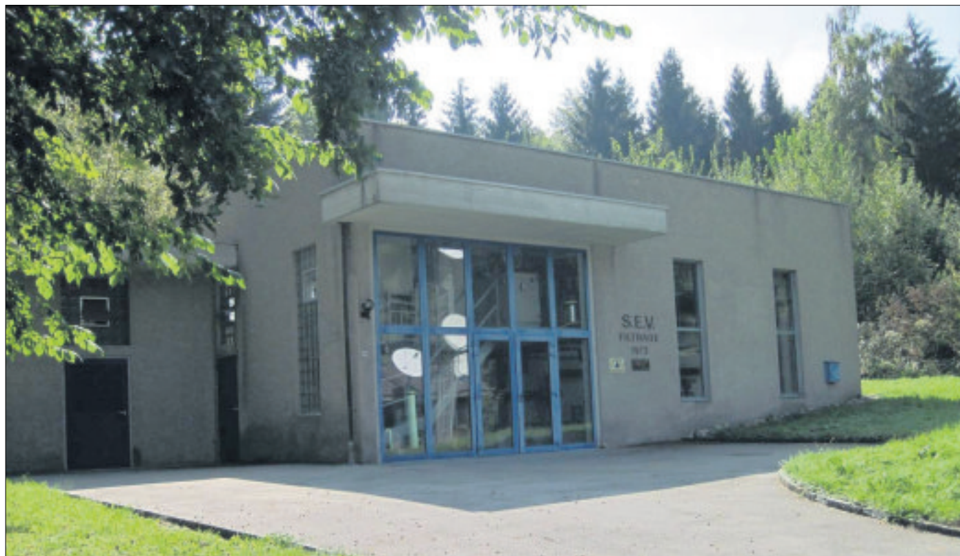
Le Syndicat des eaux de la Vendline veut rénover ses installations début 2014 mais conserve le principe du traitement de l'eau par ozonation.
