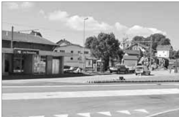
LES REUSSILLES Plus de 400 000 fr. devraient être attribués pour l'aménagement de la place de la Gare.
