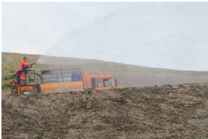
Spectaculaire, la technique du semis hydraulique sur les talus. [STÉPHANE GERBER]
