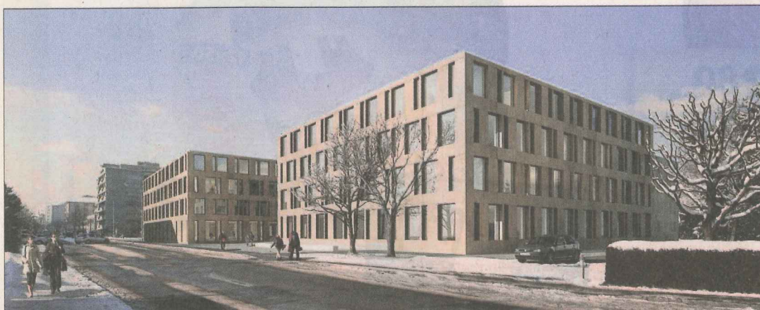
Les travaux pourront être lancés au début de l'année prochaine et le premier bâtiment du complexe pourra être opérationnel pour la rentrée 2015.
