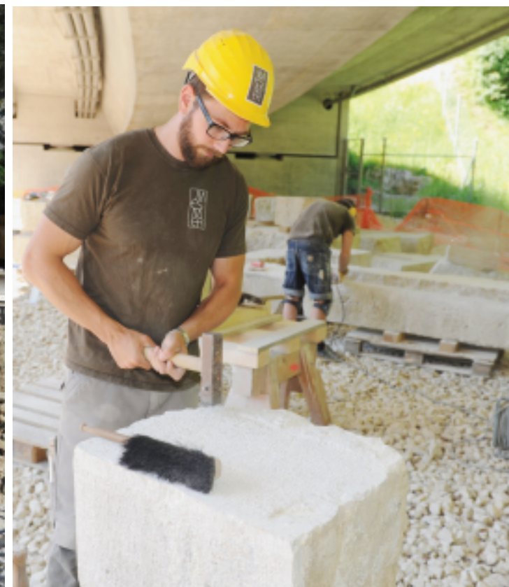
Les tailleurs de pierres sont à pied d'œuvre pour reconstituer le pont historique tout en lui enlevant de la largeur. Un travail minutieux qui durera encore quelques semaines. STÉPHANE GERBER
