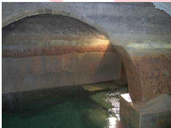
Intérieur du captage, voûtes en béton non armé, dépôts limoneux dans le fonds du bassin (© photo : bureau ATB SA)
