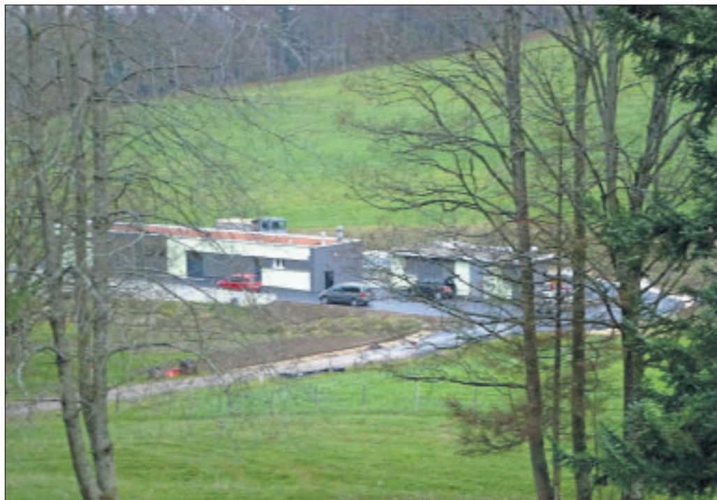
La nouvelle STEP de Saignelégier a été finalisée hier avec la réception des travaux.
