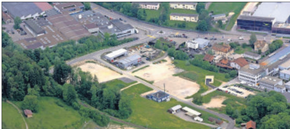
La zone industrielle des Laives est amenée à devenir une vitrine économique majeure.
