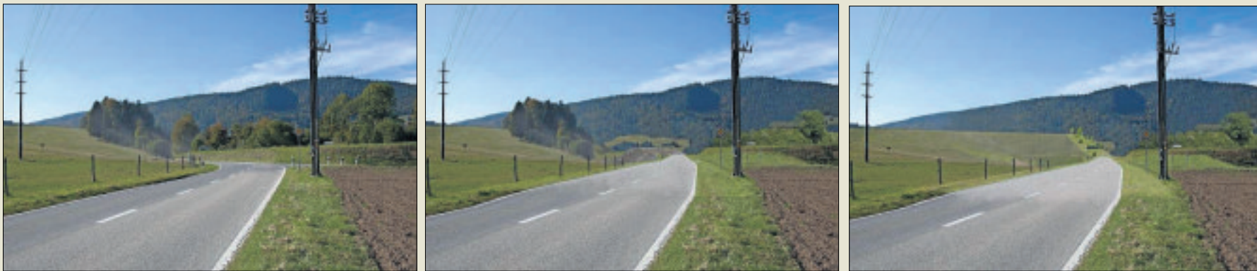
Au jeu des sept erreurs, on remarque que le tracé de la route cantonale sera déjà déplacé en 2030 (au milieu) par rapport à la situation actuelle (à gauche) et que le paysage au sud de ladite route aura changé à la fin de l'exploitation de la décharge «Celtor II» en 2065.
