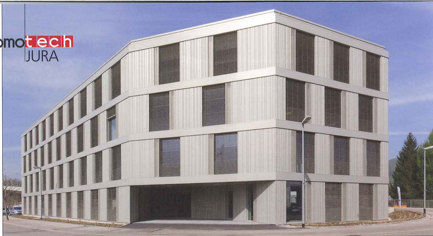
Polyadès est le premier bâtiment administratif certifié MINERGIE-P® de Delémont, chef-lieu du canton du Jura.
