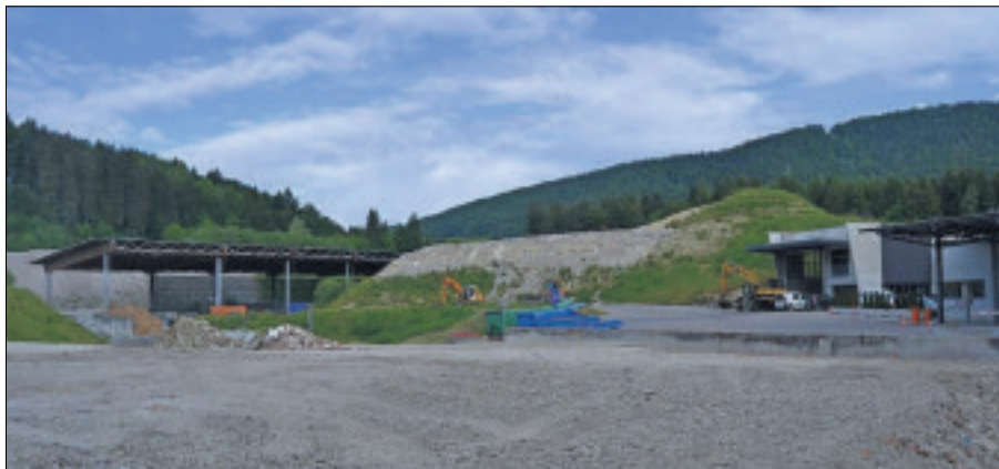
Une large surface a été dégagée pour accueillir la halle de transbordement (que l'on peut voir à gauche en arrière-plan). Le déménagement débutera cette année.
