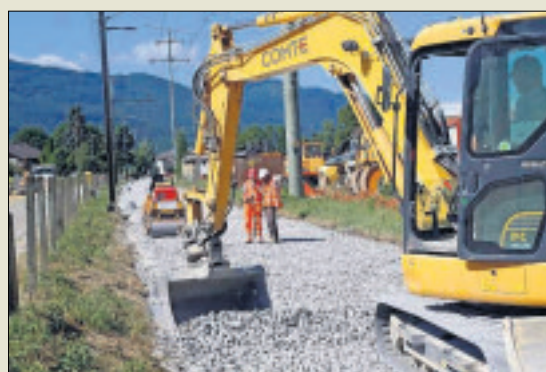
Un tout nouveau ballast est posé sur le tracé de la voie.
