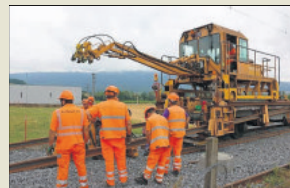
Avec ses pinces, le chantier roulant met les rails en place.
