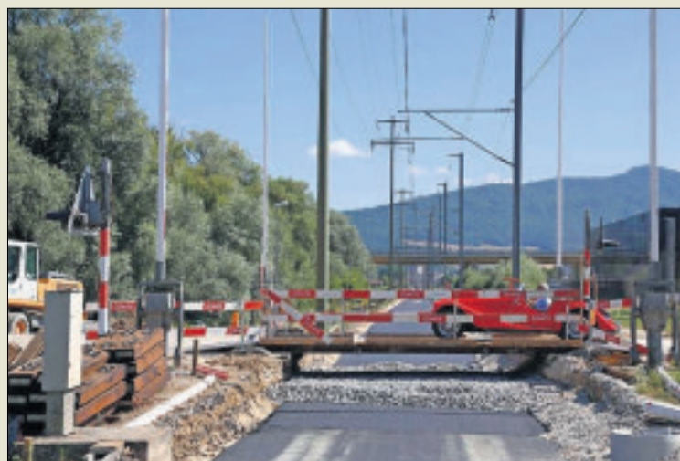
Les passages à niveau ont dû être quelque peu réaménagés.
