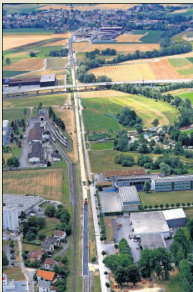
Ce chantier s'étend sur 2,4 km de Delémont à Courtételle.
